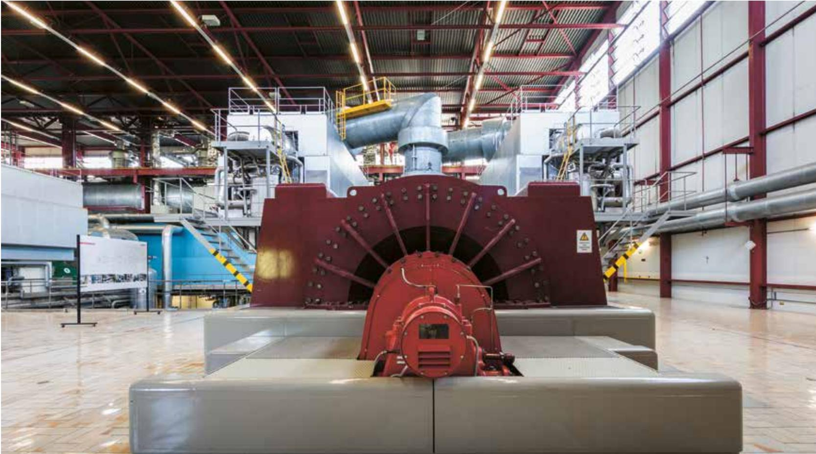
**Die Spannung eines Generators beträgt 15,5 Kilovolt. Von einem Transformator wird sie auf 220 Kilovolt erhöht und über das Unterwerk in Beznau in das Hochspannungsnetz der Schweiz eingespeist.**
